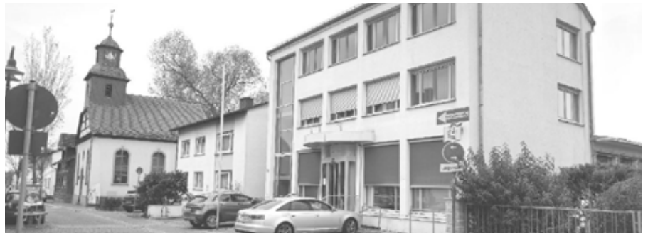
Die Filiale der Kreissparkasse in der Walldorfer Langstraße ist weg. Das "Beratungscenter" ist 1.4 km entfernt. Deshalb muss hier ein Bankautomat aufgestellt werden.
