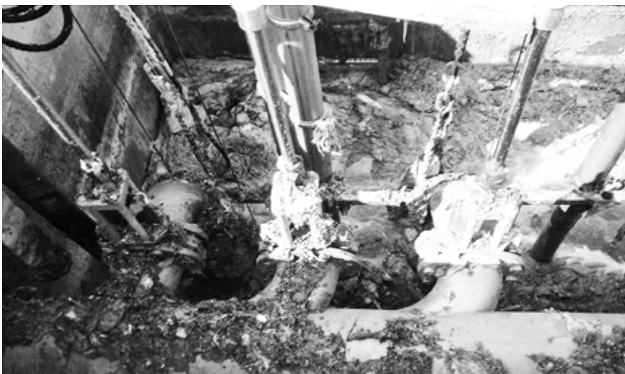
Ohne Rechen gelangen Feststoffe (Lappen, feuchte Tücher und andere Faserstoffe) in die Pumpen, die das Abwasser zur Kläranlage befördern. Die Pumpen laufen dann schwerer, verbrauchen sehr viel Strom, gehen irgendwann auf "Störung", und müssen aufwendig gereinigt werden.
